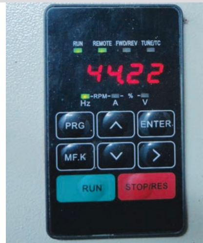
Рисунок 8 – Продуктивність видалення димососом відпрацьованих газів із теплообмінника встановлюється та контролюється на цифровому табло щитка шафи керування
