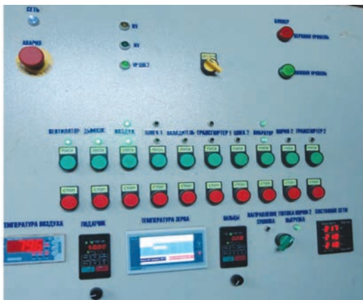
Рисунок 5 – Шафа системи управління теплогенератора «ТГБ-1,85» та зерносушильного комплексу, в складі якого змонтовано систему управління теплогенератора (загальний вигляд фронтальної частини шафи)
