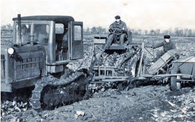
Рисунок 8 – Бурякозбиральний комбайн «СКЕМ-3» у роботі, 1960 р.
