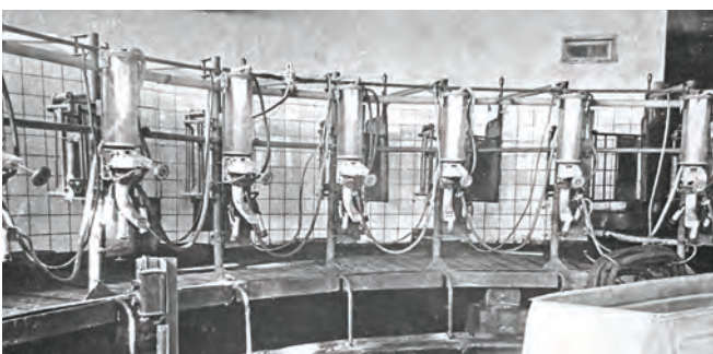
Рисунок 20 – Доїльна установка карусельного типу «КДУ-5», 1964 р.
