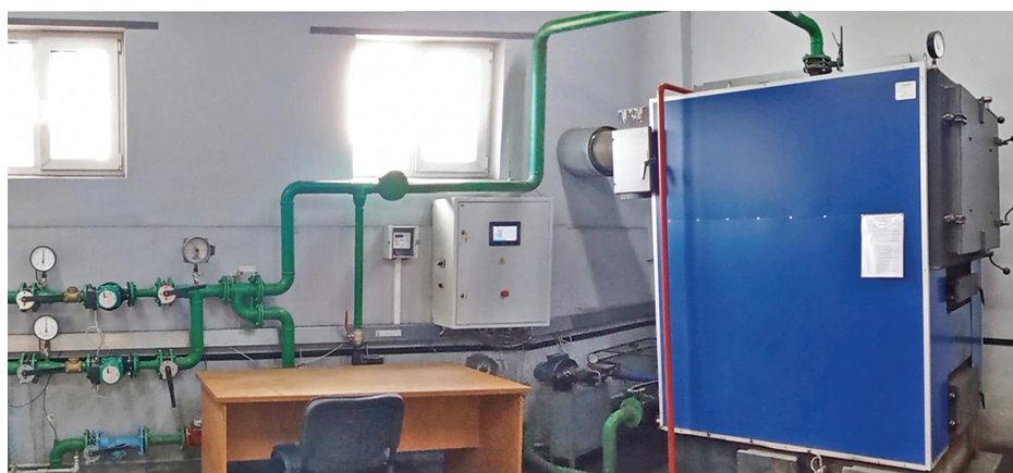
Рисунок 7— Твердопаливна котельня інституту, яка працює на січці міскантусу
